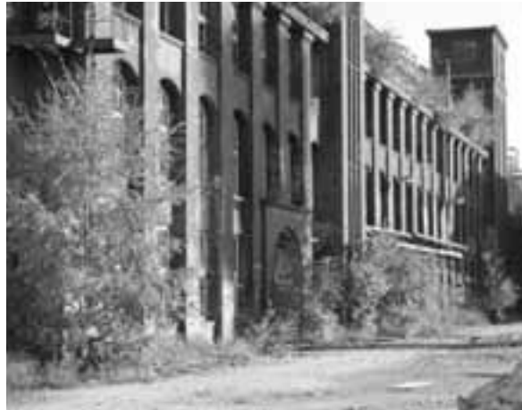
3 | Produktionsgebäude des Continental-Werks im September 2008, inzwischen abgerissen.
